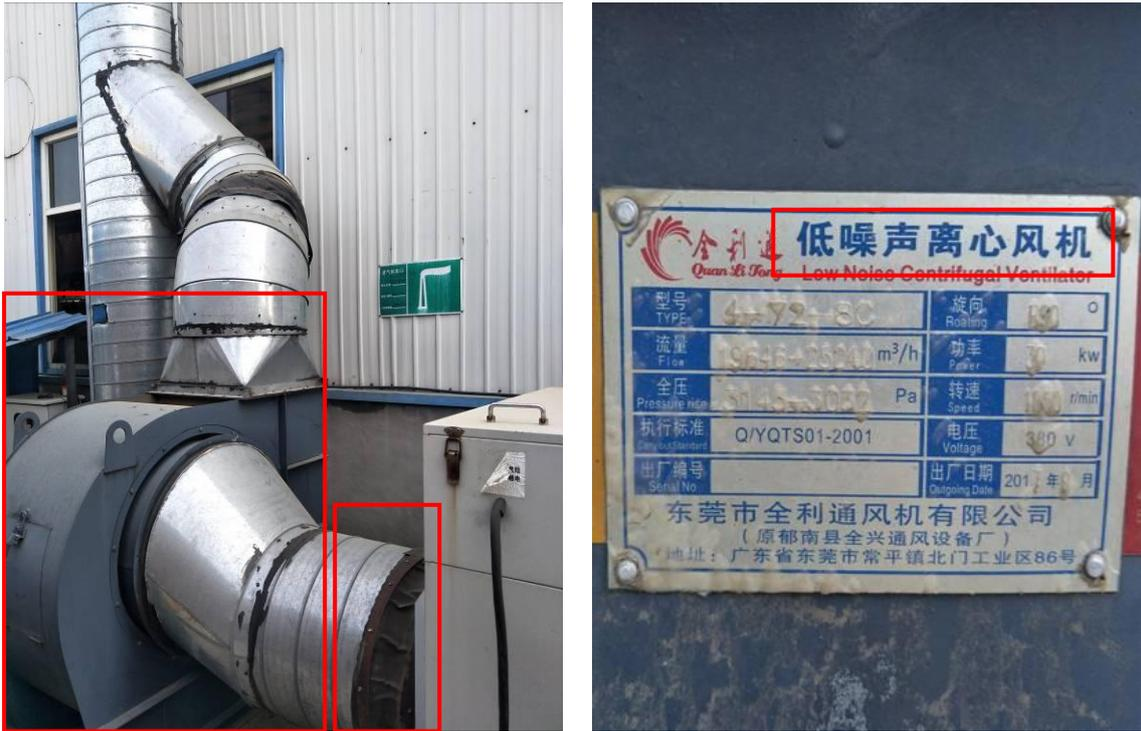
低噪声风机+管道软连接
