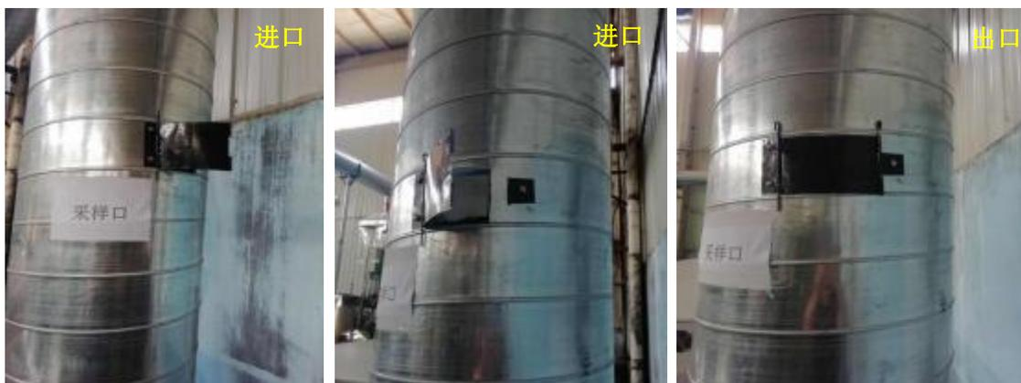
密封弹性体生产线采样口
